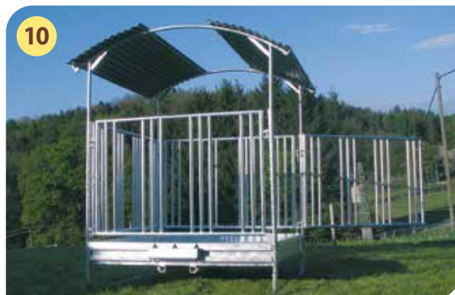
10 Danach die Dachplatten auflegen, zuerst die 2 äußeren ...
