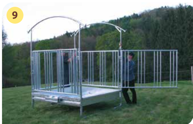
9 Das Dach ist stufenlos höhenverstellbar. Wählen Sie Ihre gewünschte Höhe. Dann mit Feststellschrauben verschrauben.
