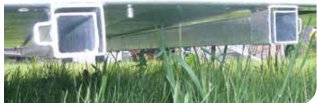
2 Vierkantrohr-Unterzüge als Verstärkung
