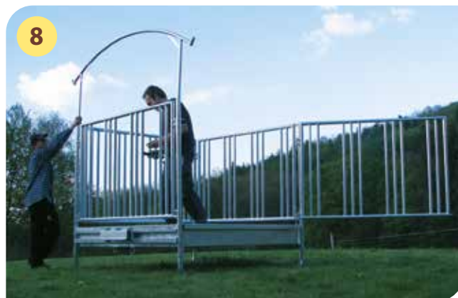
8 Das Dachgerüst gleichmäßig in die Eckrohre einführen.
