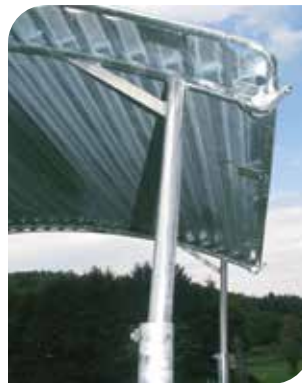
umlaufend geschützte Dachkanten
