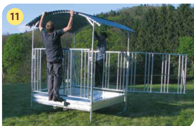
11 ... dann abschließend die Dachplatte in der Mitte auflegen.
