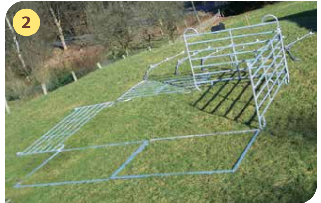
Die ersten zwei Panels als Ecke miteinander verschrauben (Schraube M8 x 100 (2) B C)
