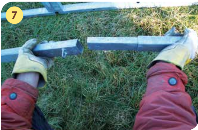
Vierkant-Verbindungsstücke ineinander stecken. D
