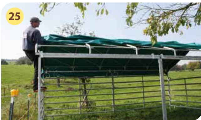
Aufziehen der LKW-Plane I auf die Dachkonstruktion
