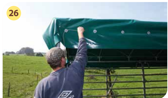
Stahlseil K durch die Ösen ziehen
