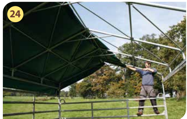
Aufziehen der LKW-Plane I auf die Dachkonstruktion
