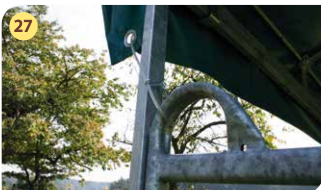
Seilende am Panel befestigen
