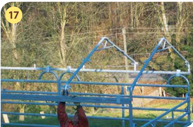
17 Winkel-Dachbögen E auf das Verbindungsstück aufsetzen, doppelte nach innen
