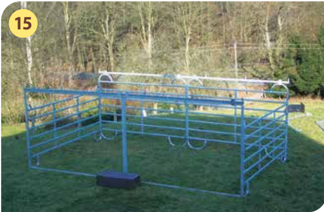
15 fertiges Gerüst aus Panels und Verbindungsstücken, bereit für die Dachkonstruktion
