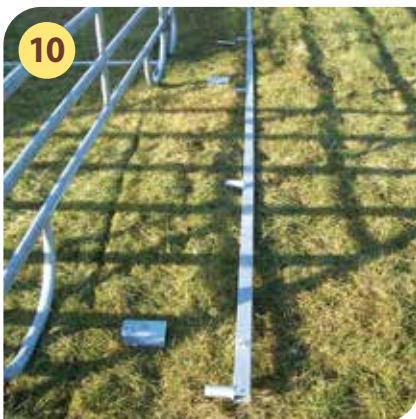
Vierkant-Verbindungsstück D , Befestigungswinkel L und Schrauben (M8 x 70 3 ) bereitlegen
