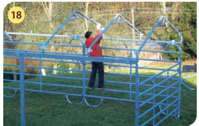
18 Winkel-Dachbögen E auf das Verbindungsstück aufsetzen
