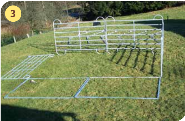
Weitere Panel-Elemente anfügen (M8 x 100 (2) C)
